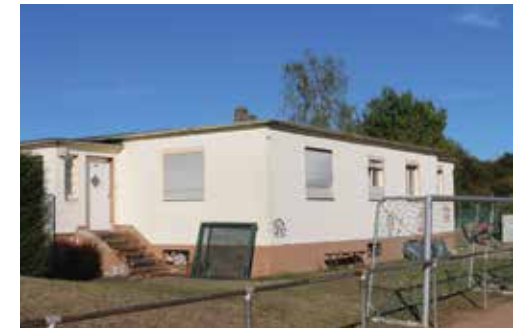
Aufgrund erheblicher Schäden der Bausubstanz durfte das Heim in den letzten Jahren nur noch zur Lagerung von Trainingsgeräten genutzt werden.
